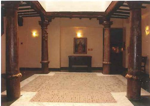
En la planta baja, cuatro grandes columnas anilladas sostienen vigas de madera que apoyan en zapatas decoradas con volutas.
