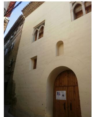
El alero de la fachada principal está realizado con diferentes hiladas de ladrillo y una teja invertida, siendo el conjunto de buen tamaño y vuelo.
