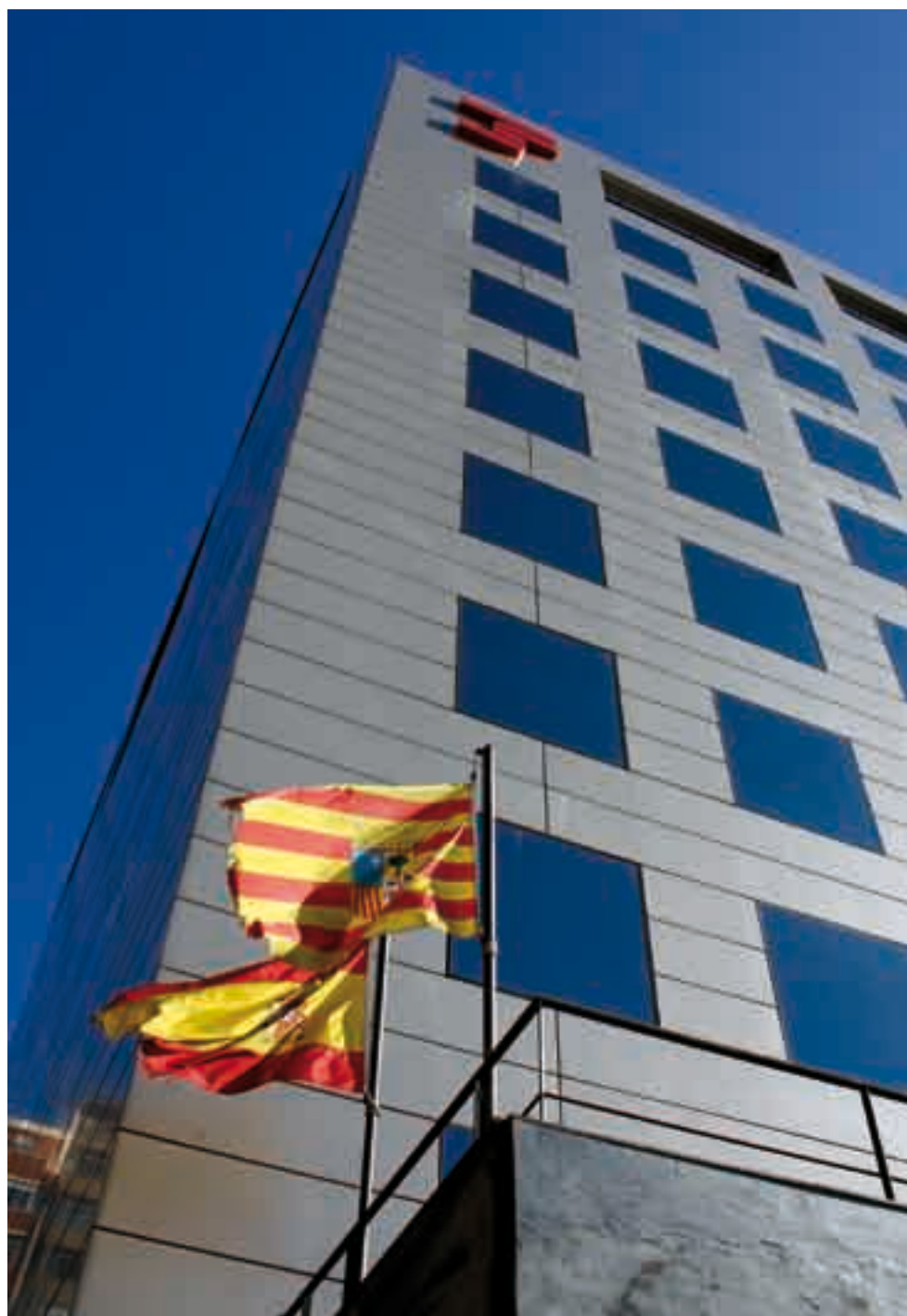
Tesorería General de la Seguridad Social en Zaragoza
